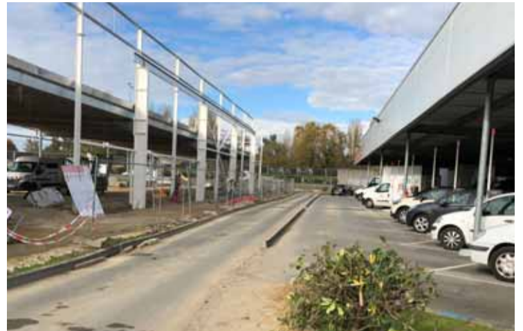
Le nouveau bâtiment en cours de construction sera situé en face de la ligne de retrait actuelle. PHOTO JOSIANE DUBARRY
