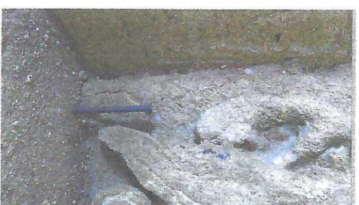
Fig. 7 détail du clou situé à la jointure entre la voussure III et le tailloir du chapiteau central de l'ébrasement dextre.
