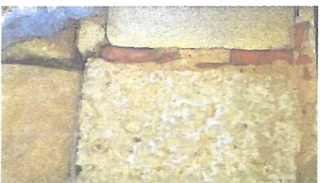
Fig. 8 détail du côté dextre de l'encadrement de la porte. Colmatage de mortier et de morceaux de briques.
