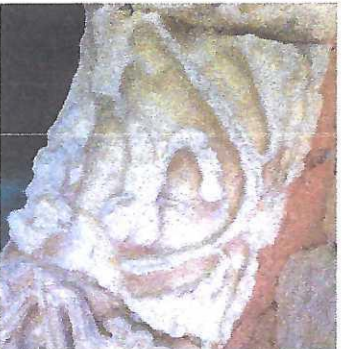
Fig. 13 détail de la voussure I. Manque de cohésion du claveau.
