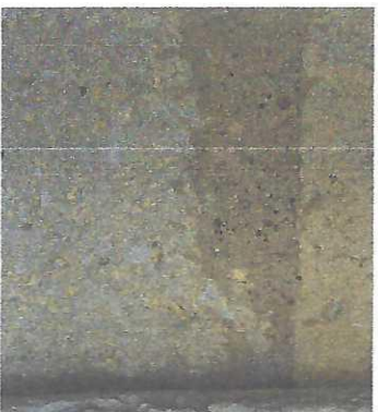
Fig. 6 détail du côté sénestre de l'encadrement de la porte. Mortier orangé plus grossier.
