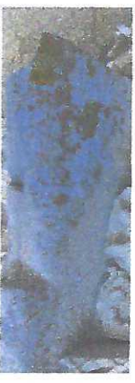
Fig. 23 détail du tailleur médian de l'ébrasement sénestre. Prolifération de lichens.
