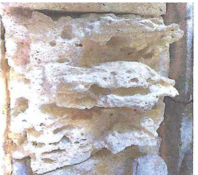
Fig. 14 détail de la voussure VI. Claveau qui présente une érosion différentielle avec une perte de constituant. Le manque observé sur le corps de l'aigle, résulte de la perte d'un fossile du calcaire coquillé.
