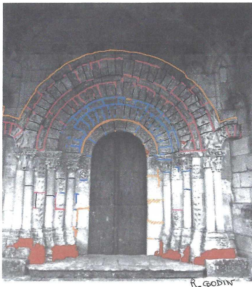
Schéma 1 : Relevé des différents mortiers de jointolement.
