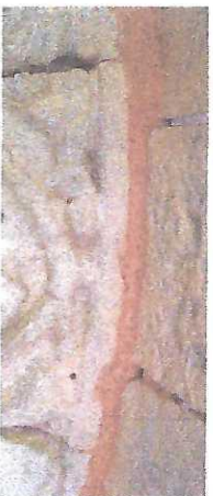
Fig. 3 détail de la voussure I. Joint de mortier de chaux aërenne et de sable non lavé, couleur jaune orangé.
