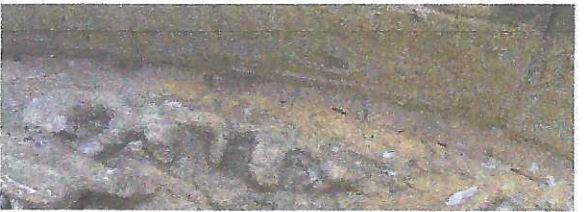
Fig. 4 détail de la voussure III, Mortier de chaux de couleur et d'aspect proches de ceux de la pierre sculptée souvent érodé.
