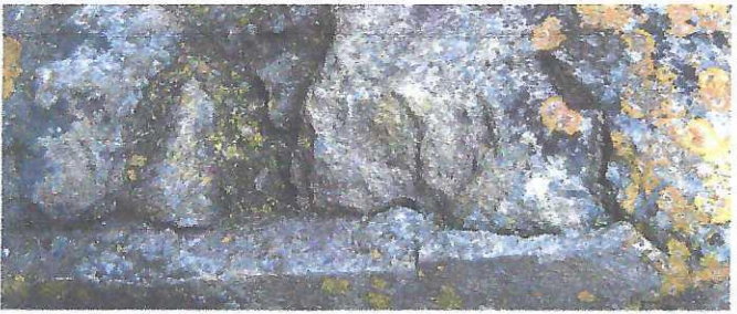
Fig. 5 détail de la base d'une colonne, ébrasement dextre. Un ciment gris recouvre la pierre d'origine.
